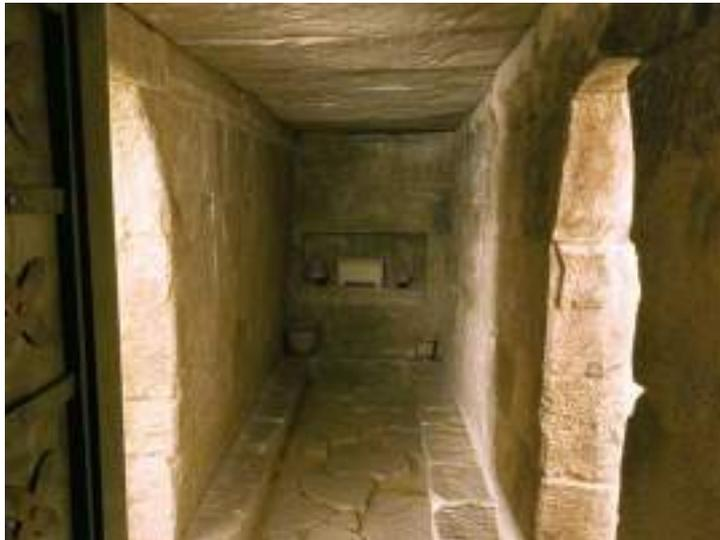
La cubierta se caracteriza por una serie de grandes losas que se apoyan en los muros de las estancias longitudinales.
